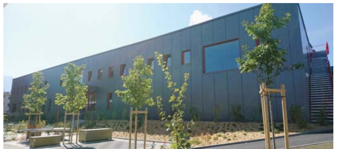
La nouvelle caserne est désormais prête à l'emploi. LDD
